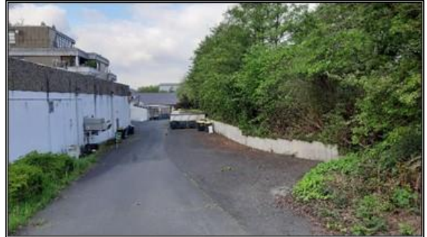
Abb. 5: Gebäude, Zufahrt und Gehölze im Nordwesten
