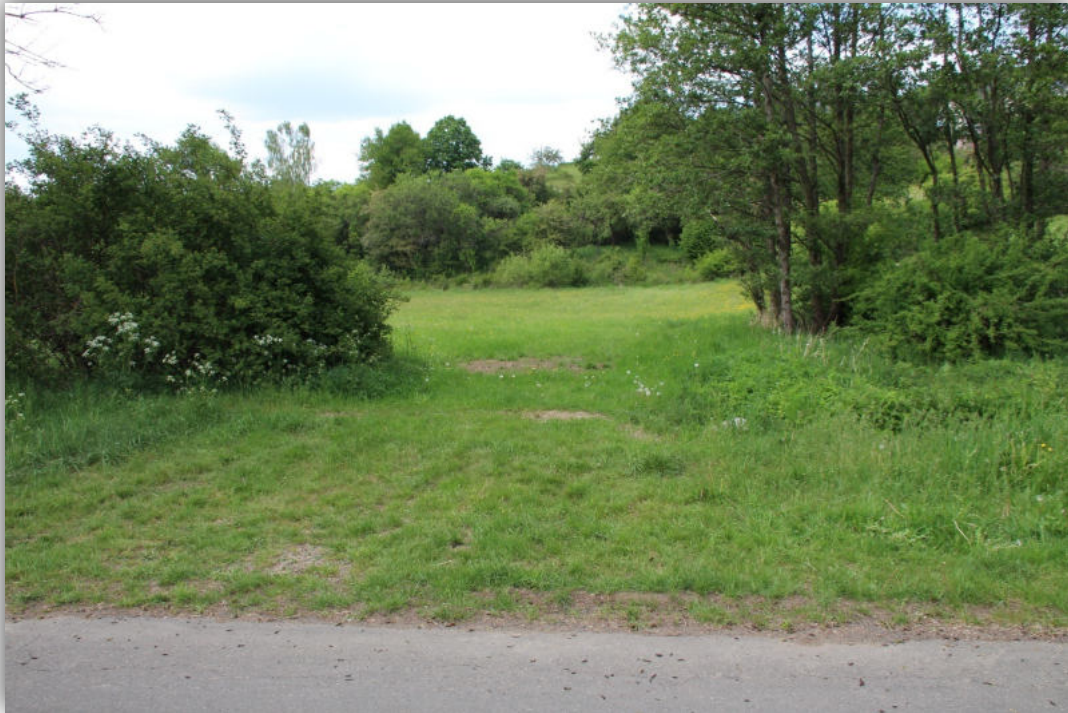
Abbildung 14: Verrohrter Bachabschnitt im Bereich einer landwirtschaftlichen Zufahrt zu einer Wiese
