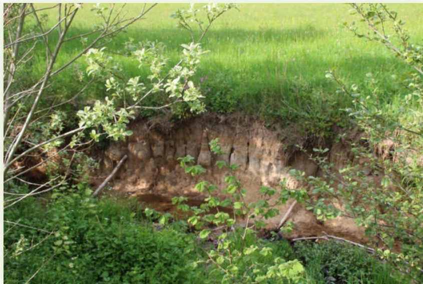
Abbildung 13: Ufererosion im Bereich eines fehlenden Ufergehölzsaumes
