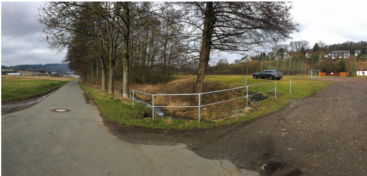
Foto 4: Blick auf die Erschließungsstraße (links im Bild) und die vorhandene Zufahrt zur geplanten Gemeinbedarfsfläche (rechts im Bild) (Foto: Ingenieurbüro Zillinger, Februar 2020)
