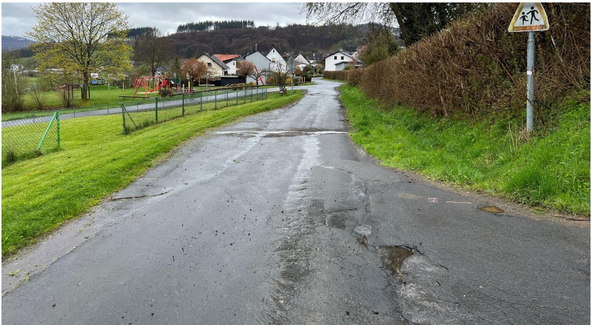
Foto 3: Blick auf den Achenbacher Weg in Richtung Süden (Quelle: Ingenieurbüro Zillinger, April 2022)
