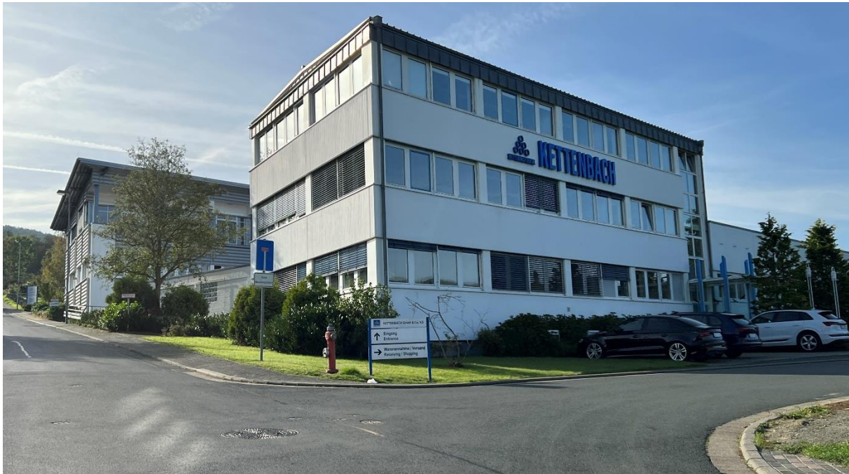
Foto 1: Blick von Nordosten auf das Firmengrundstück Straßenecke Im Heerfeld/Zum Rommelsberg
