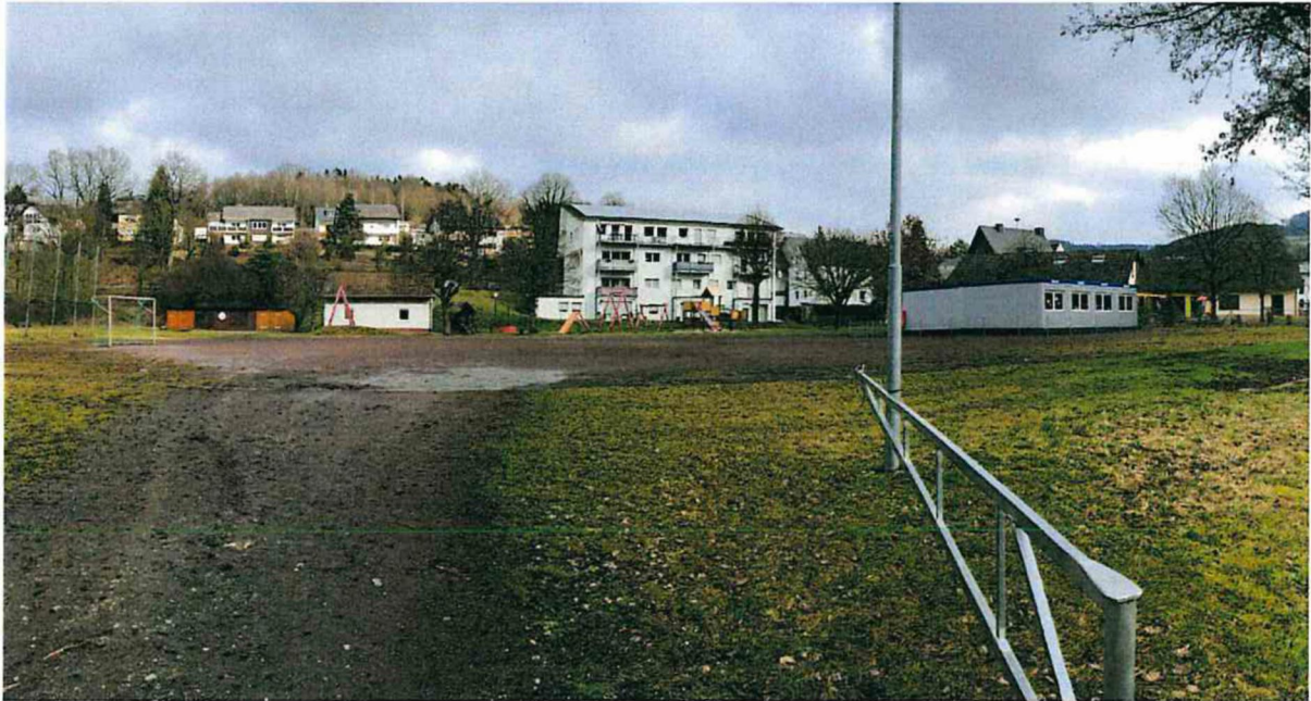
Foto 1: Blick über den Geltungsbereich der Gemeinbedarfsfläche aus Richtung Süden (Foto: Ingenieurbüro Zillinger, Februar 2020)
